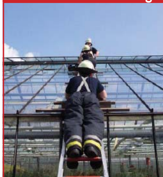
Ein Unwetter zerstört zahlreiche Gewächshäuser im Südosten Hamburgs
